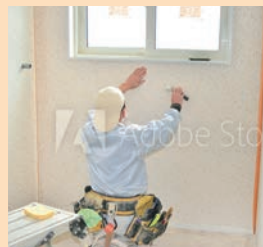
内装材・外装材 設計・改修
